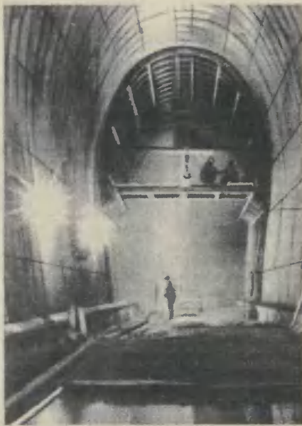
Готов еще один участок тоннеля.
